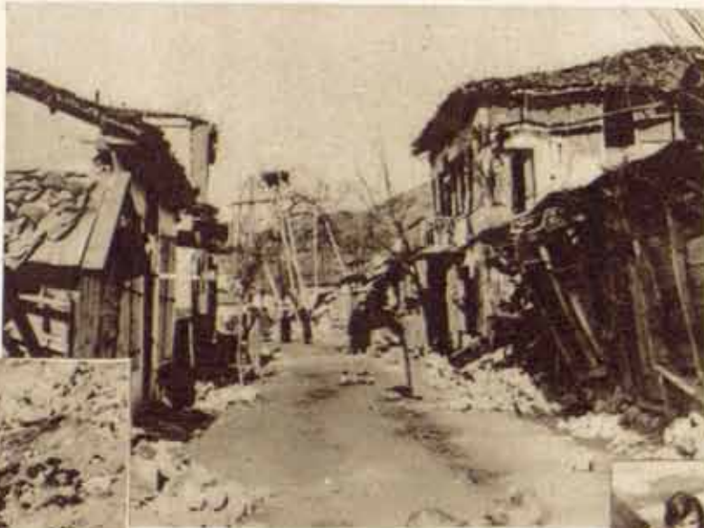
Једна разрушена улица у Пирави
