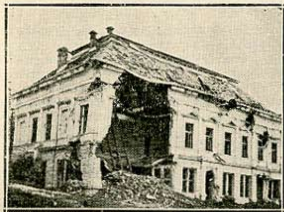
Порушена зграда у близини Калемегдана
