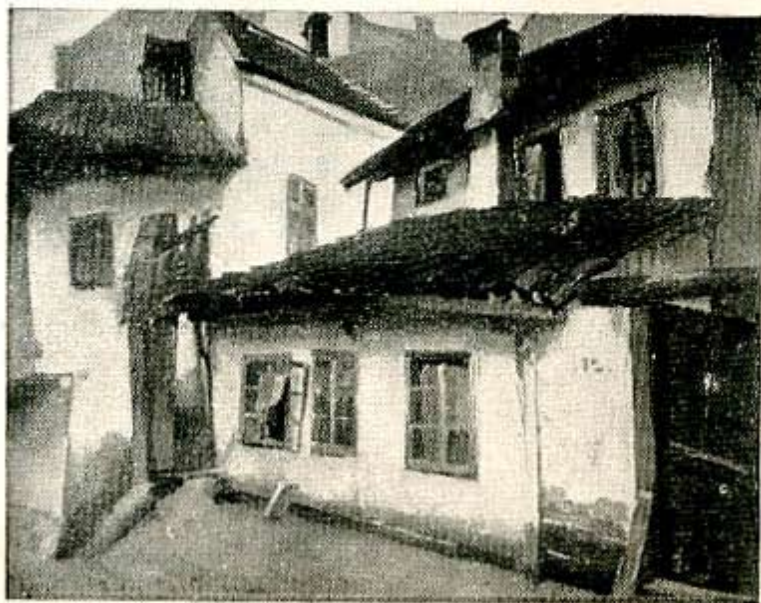
Из Црногорске улице на Варош Капији
