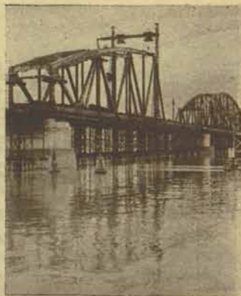
Изградња конструкције на последњем стубу.
