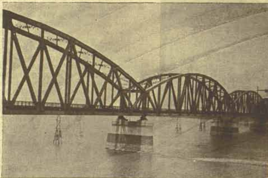
Поглед са воде на готове делове моста.
