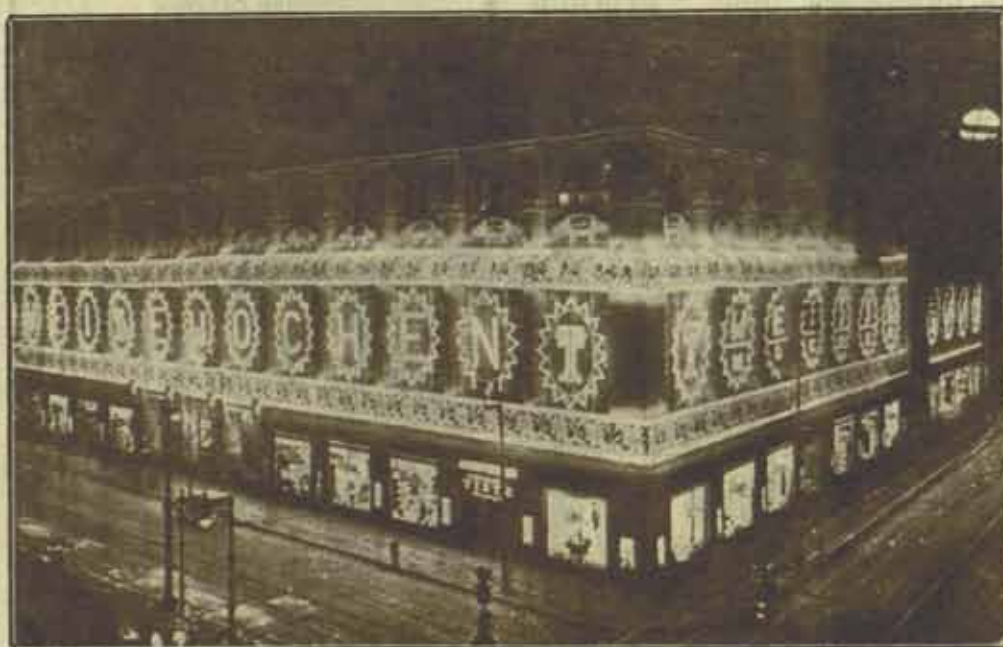
Тицова трговачка кућа у Берлину, била је уништена пре неколико дана великим пожаром. Несрећа је проузрокована дефектом у инсталацији ове некада заиста сјајне електричне рекламе.
