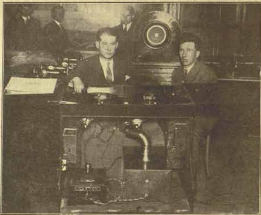
Електрични грамофон са дуплим тањирима и лаутспрекером (гласогворником) — преносником са тањира на тањир, и регулатором за пианисимо и фортисимо.
