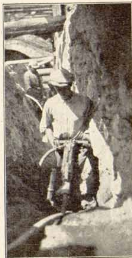
Мокролушки исцисци. Просецање шлица у сцени (од +1020 до +1030)
