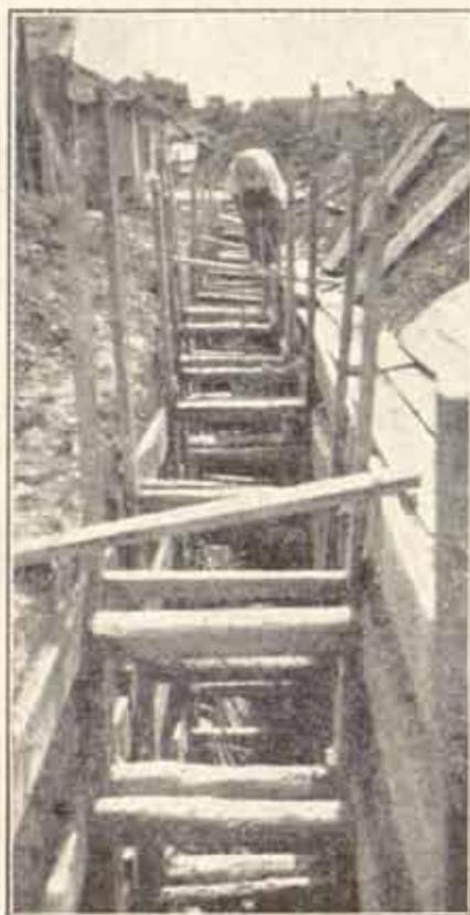
Десни колектор у ул. Франц Делере (на +700—750). Набейонирани бокони. — Профил 175 70.
