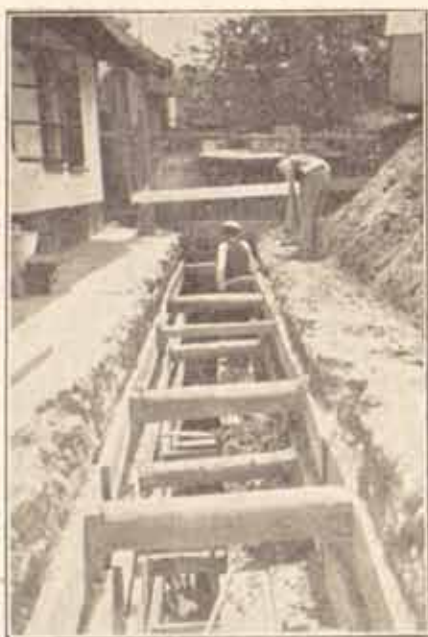
Десни колектор у улици Франше Денере. Копање рова кроз Јашаган Мажу. Радови у 1931 год.
