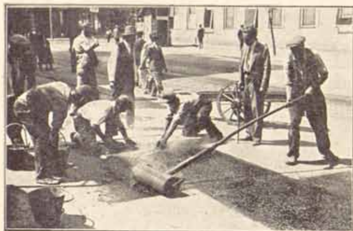
Оправка асфалтног трошоара у Поенкаревој улици.
