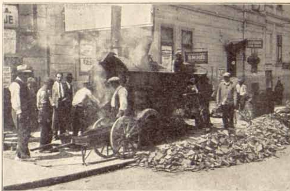
Сиремање асфалтне мешавине за оправку
